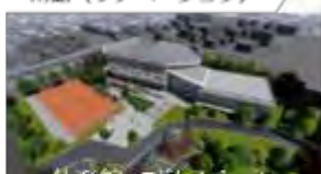
体育館、こどもスペース 調理室ほか
