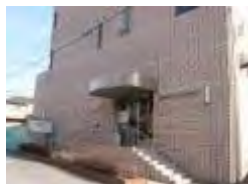
1992 (平成4年) 藤崎図書館
